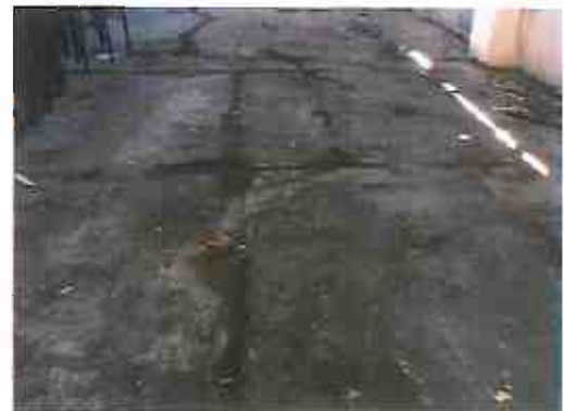
PISO DE ACESSO COM REPAROS DAS FISSURAS
