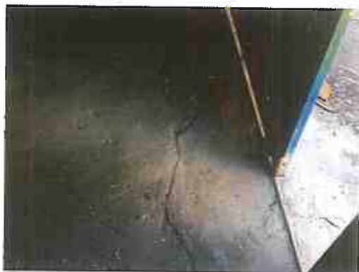
PISO CIMENTADO SEM ACABAMENTO
