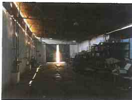
VISTA GERAL DO GALPÃO
