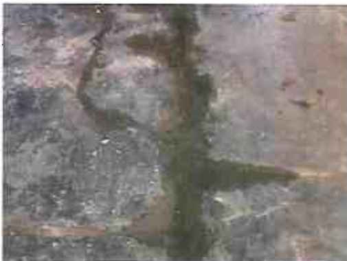
PISO DE ACESSO COM REPAROS DAS FISSURAS
