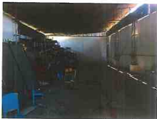
VISTA GERAL DO GALPÃO
